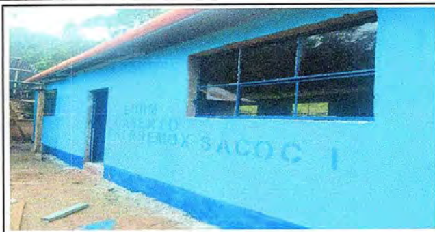
Foto 2: Colocadas las ventanas de metal con vidrio en ambos extremos para una mejor iluminación del aula.
