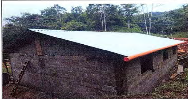
Foto 4: Se cambió totalmente las láminas anteriores por láminas troqueladas, además se le colocó canales para la caída del agua.
