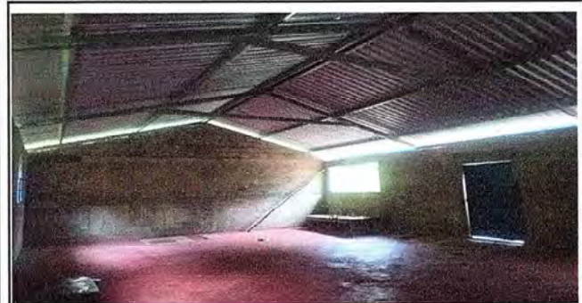
Foto 3: Se cambió totalmente las vigas por costaneras.
