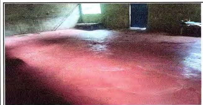
Foto 5: Se mejoró el piso del aula con piso nuevo.
